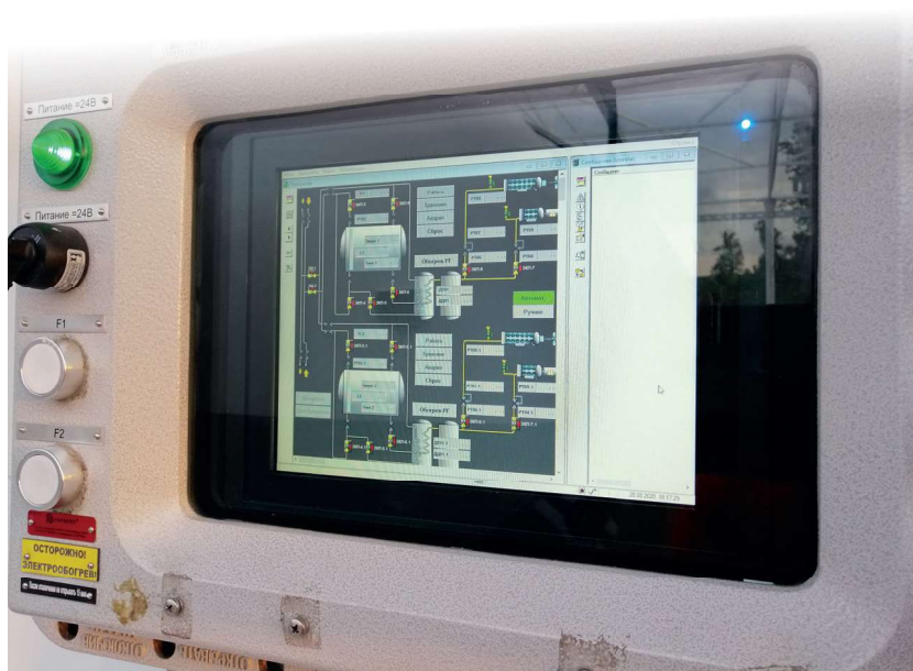
Рисунок 3. Пост управления бункеровкой – резервный пост управления КБГС
